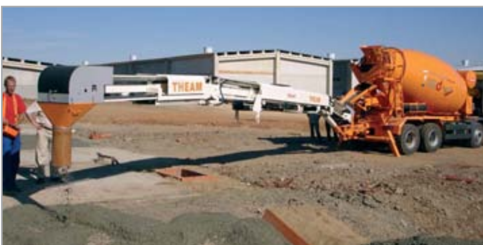
Cinta transportadora sobre hormigonera.
